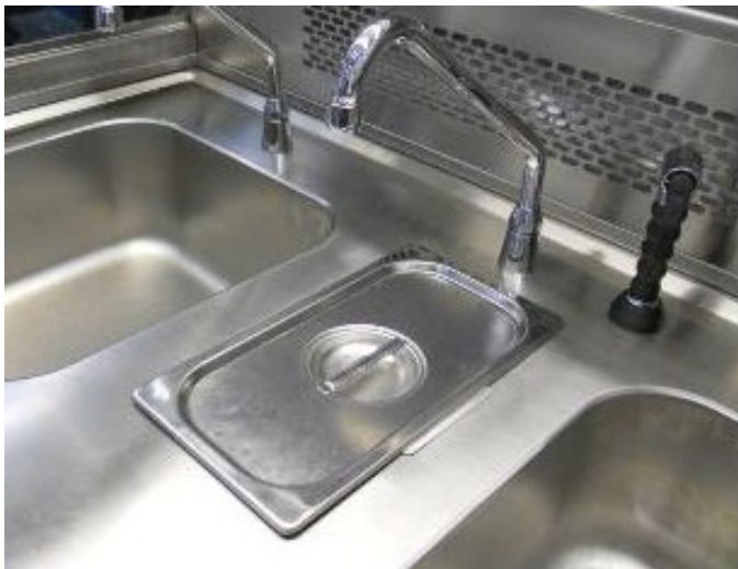
Afdækning til formalinvask
